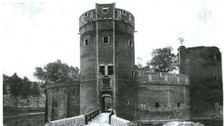
Het kasteel bij de aanvang van de tweede fase van de restauratie in 1929
